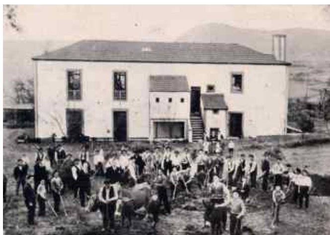
Vecinos que desinteresadamente colaboraron a la preparación del campo de deportes (Albor, revista escolar. Coirós enero de 1936).
